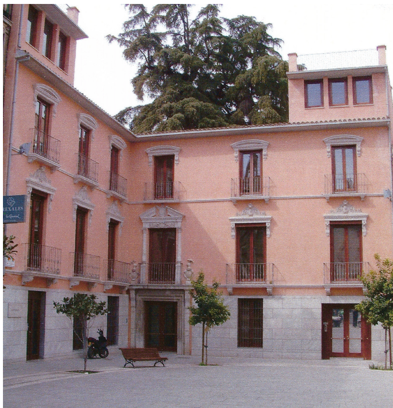
Colegio Arquitectos Granada (2002)
